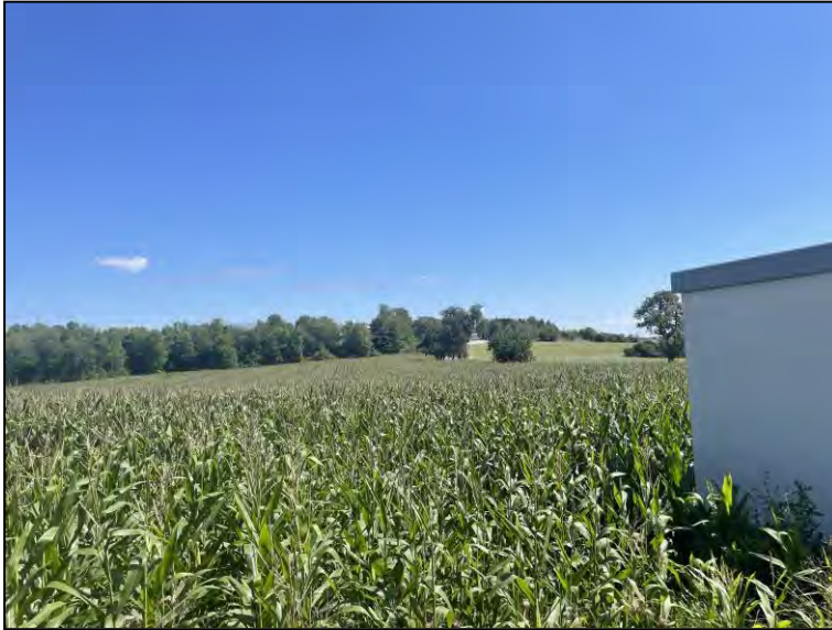
Abb.: Blick von Trafostation in Richtung Bergfeld/Ademco
